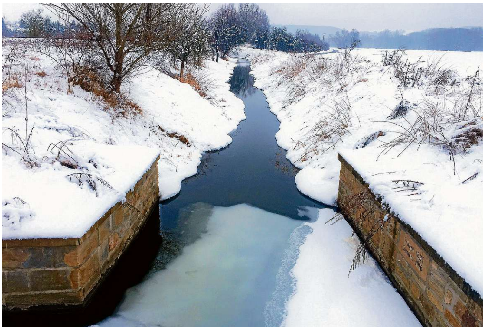
An der verschneiten Floßgrabenbrücke Nummer 1 in Crossen an der Elster.
