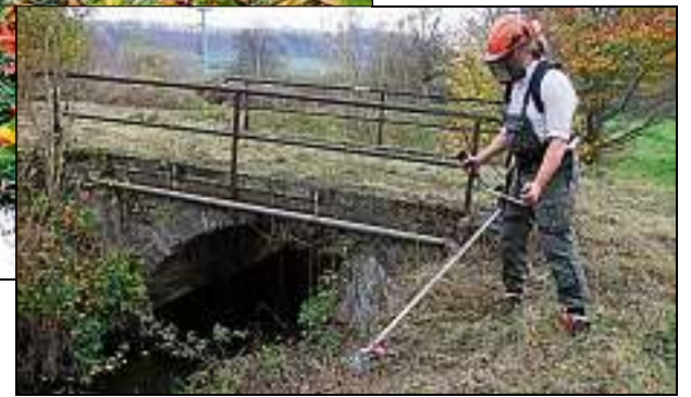
Helmut Wunderlich rückt mit einer Benzin-Sense dem Gestrüpp neben der alten Floßgrabenbrücke zu Leibe.
